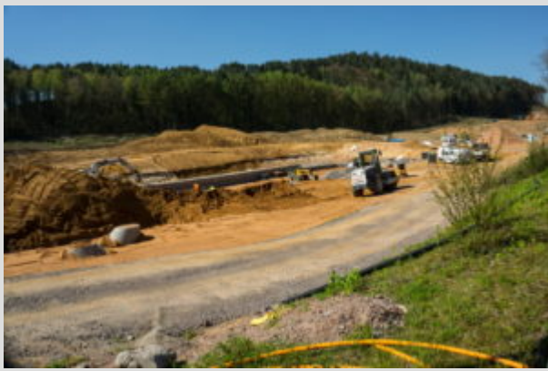
Foto: Im künftigen Interkommunalen Gewerbegebiet sind zahlreiche Baumaschinen am Werk, die das Gelände für die Bebauung herrichten. Es wird eine Herausforderung sein, dieses Gelände als großen Park&Ride-Parkplatz für den Rheinland-Pfalz-Tag am letzten Juniwochenende herzurichten. (ran)
