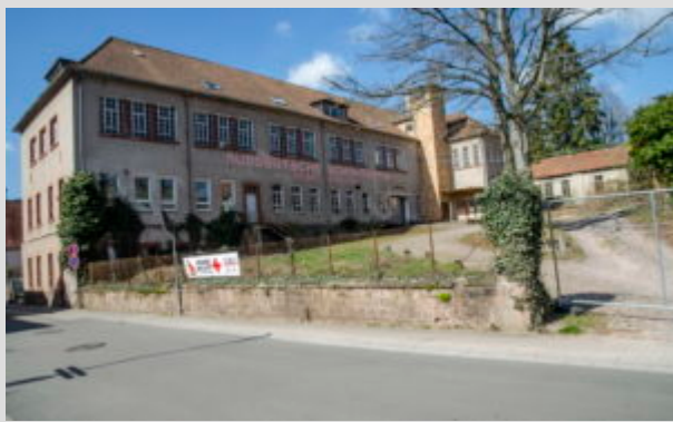
Foto: Die ehemalige „Süddeutsche Schuhfabrik“ wird abgerissen, an ihrer Stelle entsteht die neue Kita „St. Elisabeth“. Die neuen Pläne sehen vor, dass der Baukörper rund 18 Meter an die Dahner Straße (im Vordergrund) heranreicht. Zwischen Straße und Gebäude entsteht ein Spielbereich für U3-Kinder (ran)
