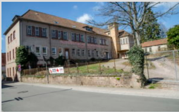
Foto: Die ehemalige "Süddeutsche Schuhfabrik" wird abgerissen, an ihrer Stelle entsteht die neue Kita "St. Elisabeth". Die neuen Pläne sehen vor, dass der Baukörper rund 18 Meter an die Dahner Straße (im Vordergrund) heranreicht. Zwischen Straße und Gebäude entsteht ein Spielbereich für U3-Kinder (ran)
