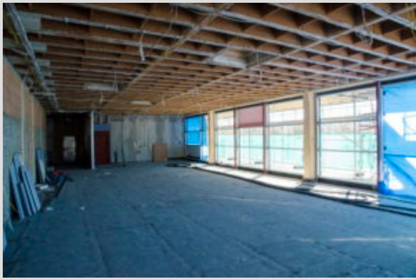
Foto: Der Kreis als Schulträger der Realschule plus Hauenstein investiert brutto 930.000 Euro in den Umbau der bisherigen Pausenhalle in eine rund 170 Quadratmeter große Mensa, die zum Schuljahresbeginn 2019/20 fertiggestellt sein soll. (ran)
