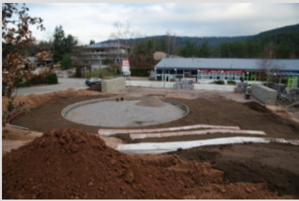
Foto: Der Platz an der Kreuzung Industriestraße/Bergstraße wird im Zuge der Attraktivitätssteigerung der Schuhmeile gestaltet und nimmt bereits Gestalt an. In der Sitzung vergab der Rat den Auftrag für eine Seilnetzpyramide, die in der runden Fläche im Zentrum des Platzes installiert wird. (ran)
