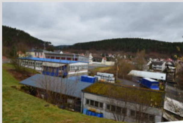
Foto: Die Tage der alten THW-Unterkunft, die einst als Werkstatt zur Jubo-Schuhfabrik gehörte, sind gezählt. Am 29. April beginnt der Abriss des Gebäudes, das einer neuen THW-Heimat weichen muss. (ran)
